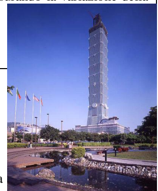
Figura 6. Il grattacielo Taipei 101 (Taipei, Taiwan, Cina) è attualmente il più alto edificio del mondo, con una altezza di 508 m, una sezione di 60 m × 60 m e un peso totale di circa 700 000 tonnellate. Le oscillazioni di questo grattacielo hanno un periodo di circa 6 secondi.
