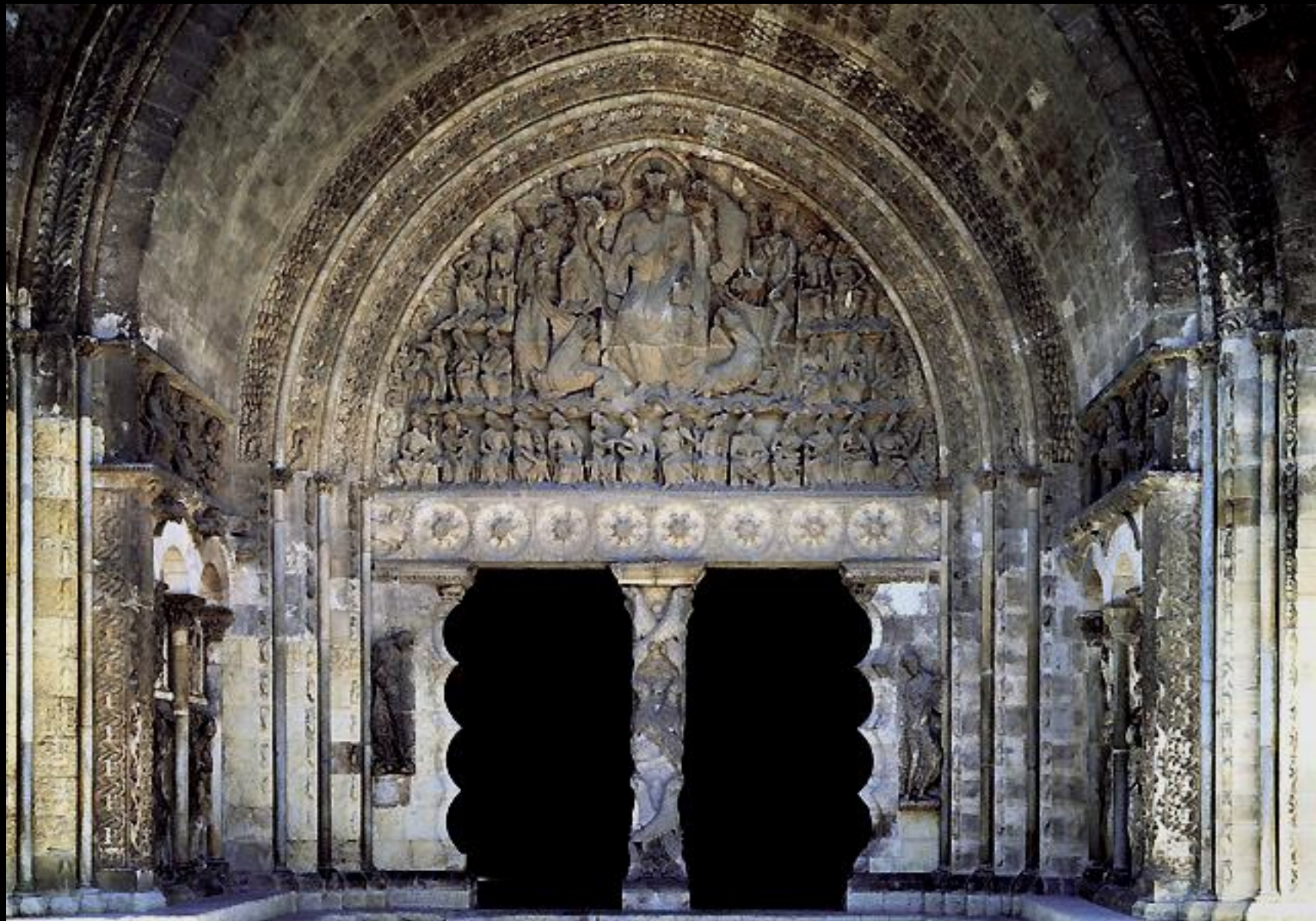
Moissac - Chiesa abbaziale di San Pietro - Portale meridionale - 1120-1135 ca
